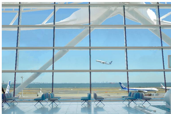
第2ターミナル国際線出発ロビー（外観・内観）
